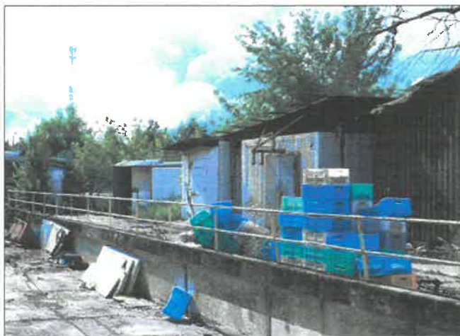
chłodnia stacjonarna zabezpieczona wiata (id. bud. 338/4.2)
